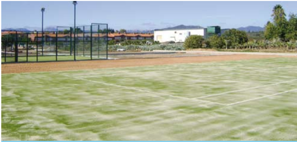
Ja està feta la pista de tennis amb gespa artificial i arena de quars
