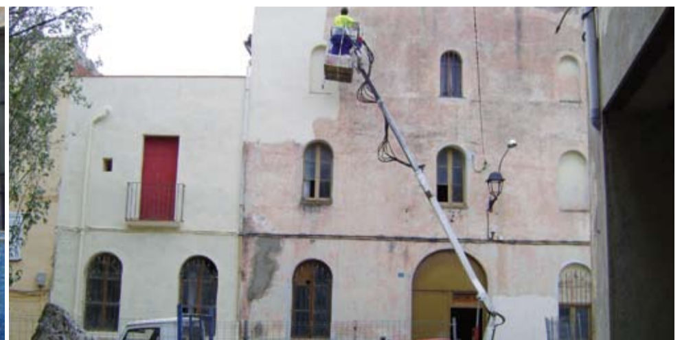
Amb l'interior de l'edifici completament apuntalat s'ha sanejat la façana posterior i s'ha pintat la façana principal
