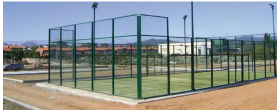
El camp de pàdel està completament acabat
