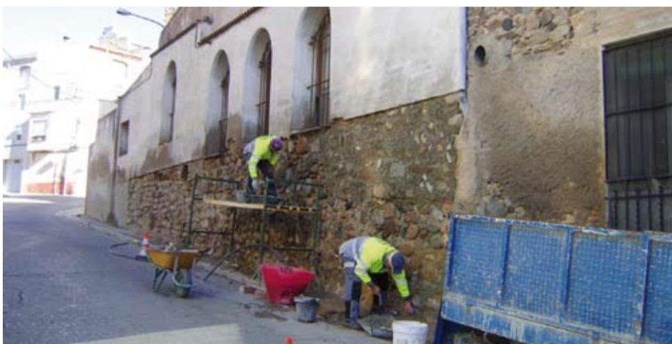
Amb l'interior de l'edifici completament apuntalat s'ha sanejat la façana posterior i s'ha pintat la façana principal
