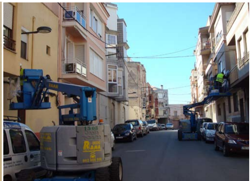
Les obres de renovació de l'enllumenat públic han substituït les lluminàries d'una part important dels carrers del poble. Els nous llums representaran un important estalvi econòmic, ja que donen una millor il·luminació amb un menor consum energètic.
