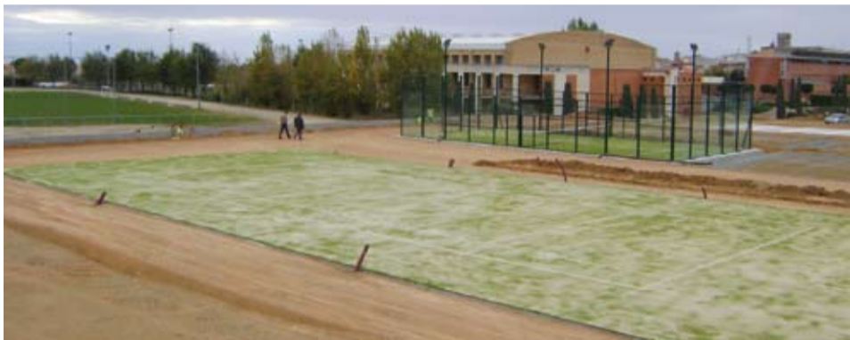
Les noves instal·lacions s'integren amb la zona esportiva existent
