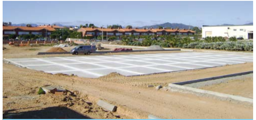
La pista poliesportiva està a punt per col·locar-hi el terra de gres
